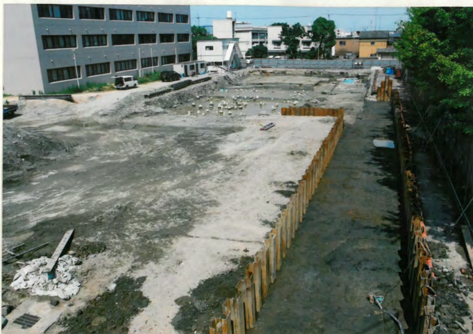
調査地全体 (手前：共同溝2-4 奥：共通棟)
