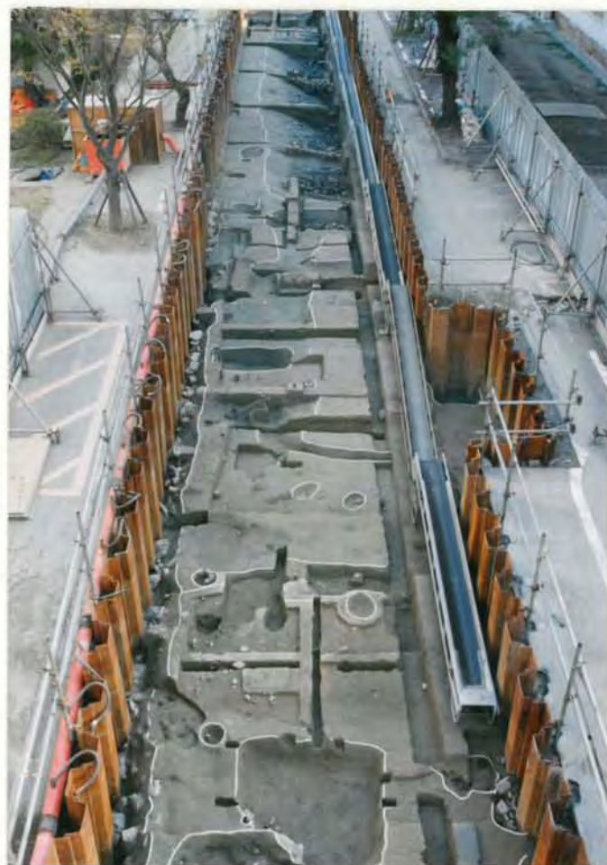
第1遺構面掘り下げ状況
