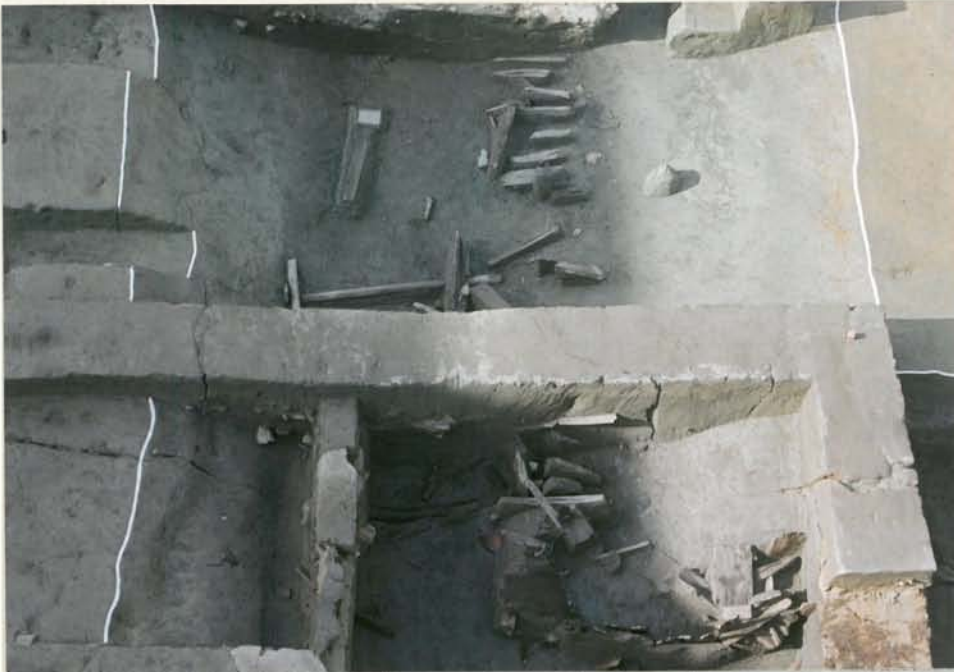
大溝 SD03 ・ SD04 と土留の杭列
