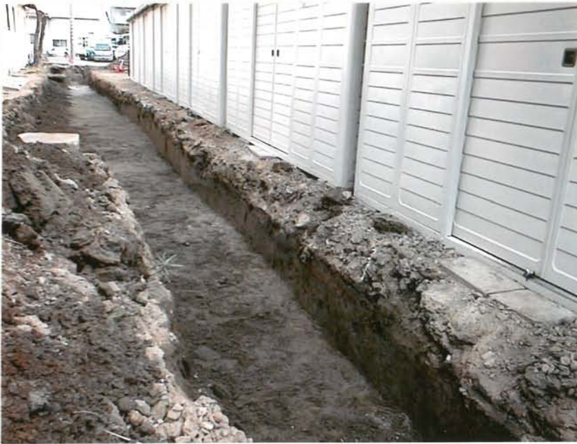
②トレンチの状況
