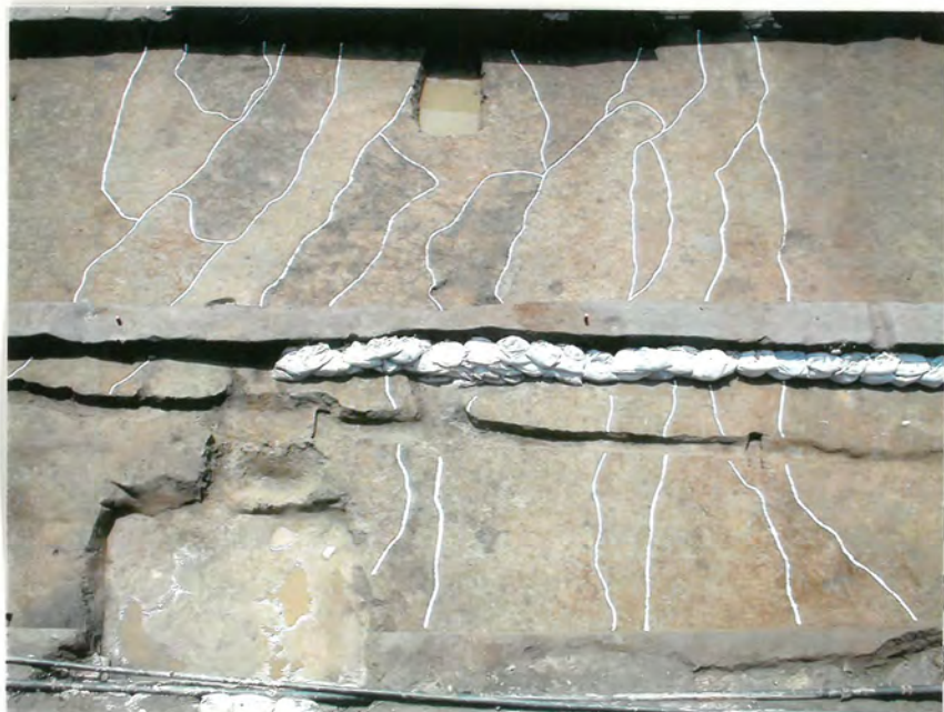
造成した盛土の平面状況 東より
