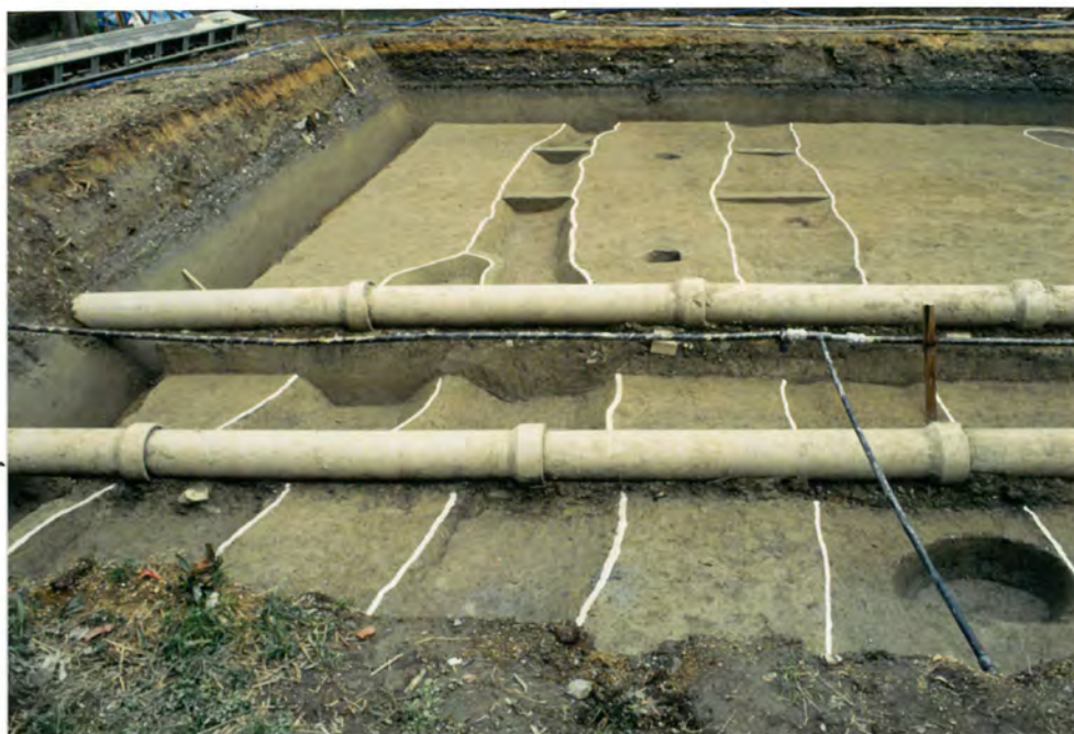
SD01・02・03完掘状況（西から）
