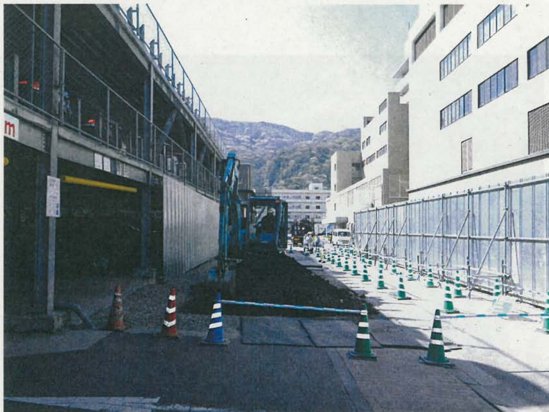
東区重機掘削 北より
