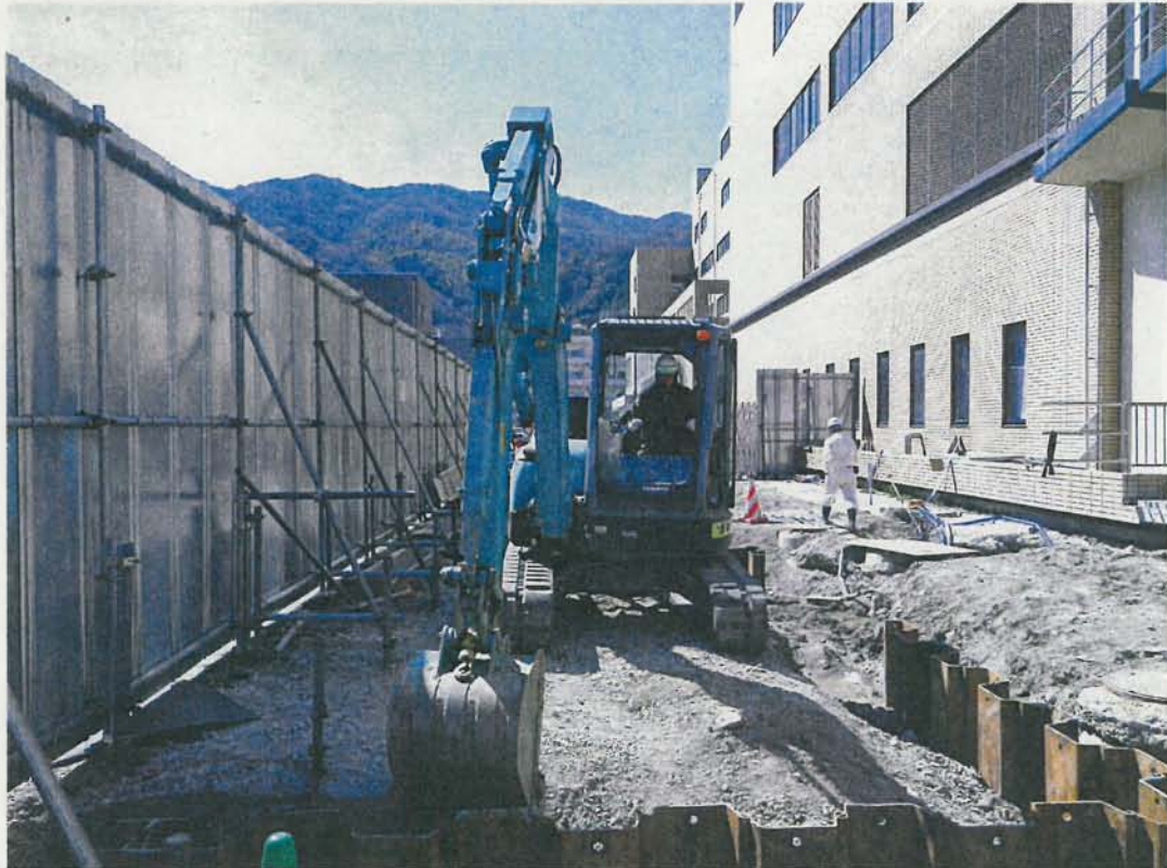
西区重機掘削 北より
