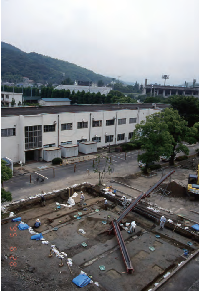
a. 調査区付近全景（北東から）
