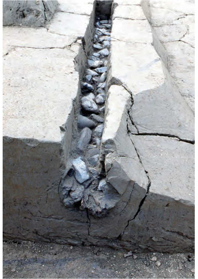
b. 暗渠 1 完掘状況 (北から)
